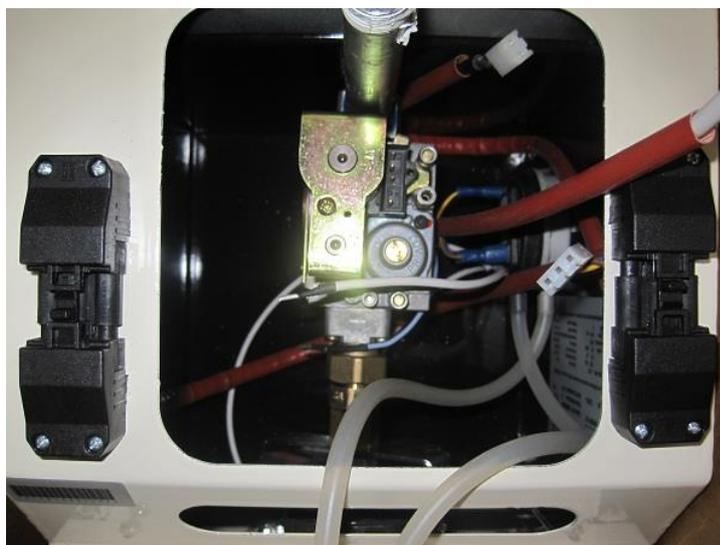
Figura 3 – Connettori per collegamento elettrico
